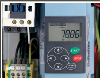
Doppie velocità per ogni movimento per rendere più sicure e rapide le movimentazioni; traslazione e scorrimento sono pilotate con inverter SWF TravelMaster.
