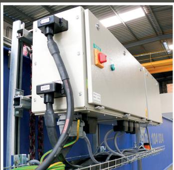
Connessioni elettriche efficienti e sicure eseguite con connettori presa-spina numerati.
